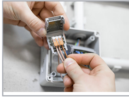
Verdrahtete Klemme in die Gelbox einlegen.
